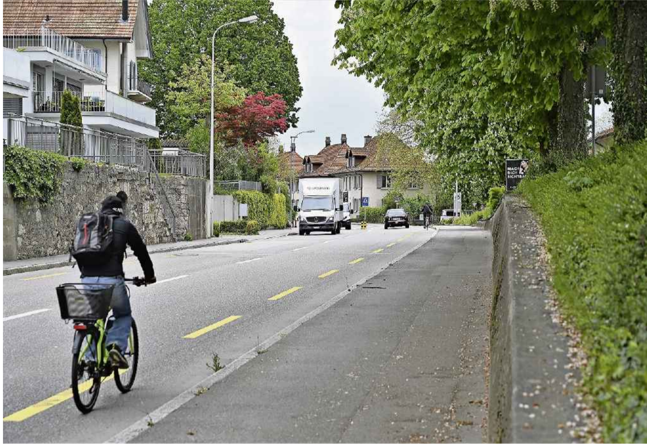
Die Aarauenerstrasse (respektive Erlinsbacherstrasse) wird täglich von 11 000 Fahrzeugen genutzt.
