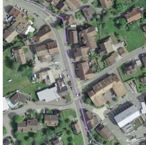
Historischer Ortskern Obererlinsbach
